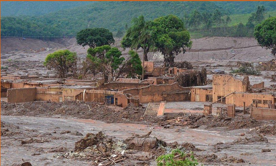
Edifícios destruídos após Desastre em Mariana (Foto: Agência Brasil).
